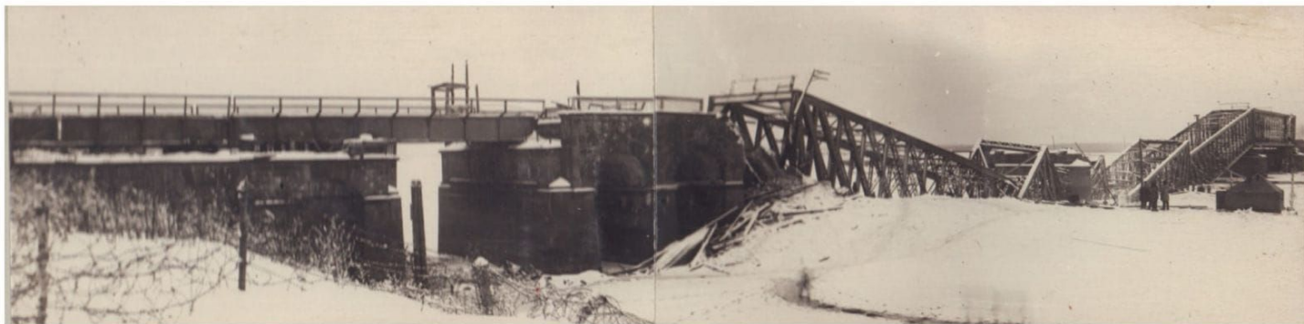
Восстановление Волховского моста на 126 км трассы Ленинград – Москва. Общий вид. 1944 г.
