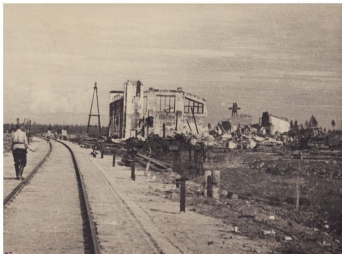
Паровозное депо на станции Мга, разрушенное во время войны. 1942 г.
