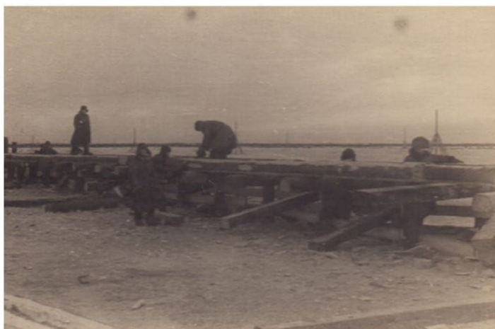
Строительство железной дороги Поляны – Шлиссельбург. Укладка рельсовых путей на мосту через Неву. Январь 1943 г.
