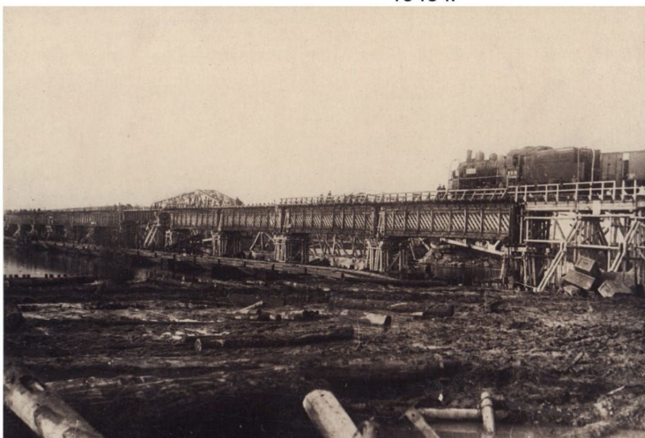
Восстановленный мост через реку Волхов у станции Кириши. Октябрь 1943 г.
