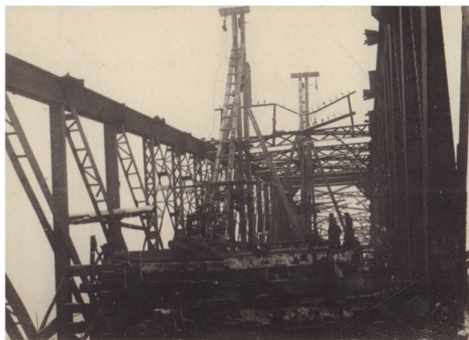
Восстановление Волховского моста на 126 км трассы Ленинград – Москва. Работа копров. 1944 г.
