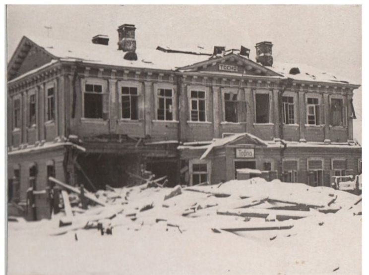
Разрушение пассажирского здания на станции Тосно. 1941 г.
