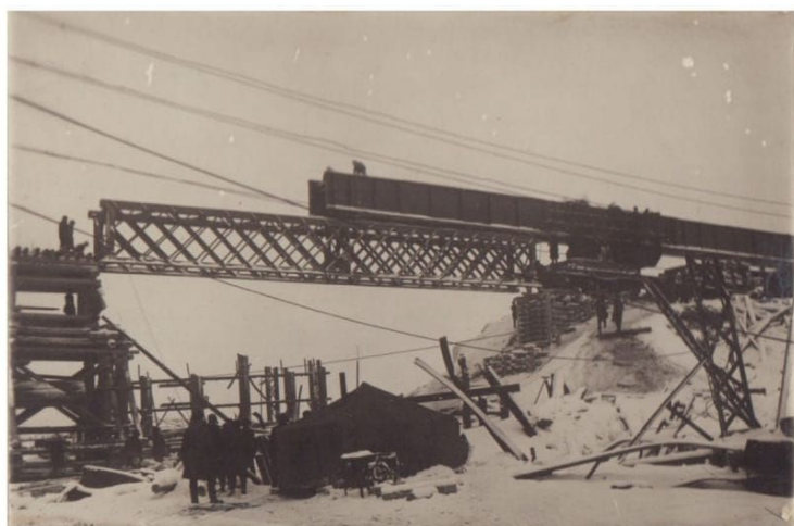
Восстановление Волховского моста на 126 км трассы Ленинград – Москва. Надвижка пролётных строений. 1944 г.
