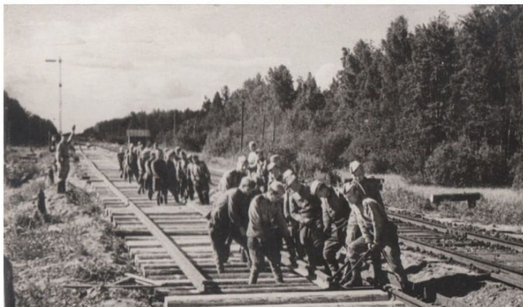
Укладка второго пути на подходе к станции Селище линии Ленинград - Москва. 1945 г.
