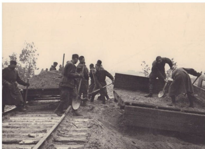
Строительство подъездных путей в бухте Осиновец. 1942 г.
