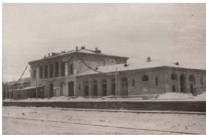
Вид восстанавливаемого здания вокзала на станции Детское Село со стороны путей. 1945 г.
