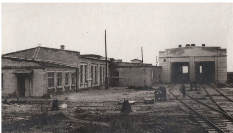
Общий вид капитально восстановленного паровозного депо на станции Предпортовая. 1945 г.
