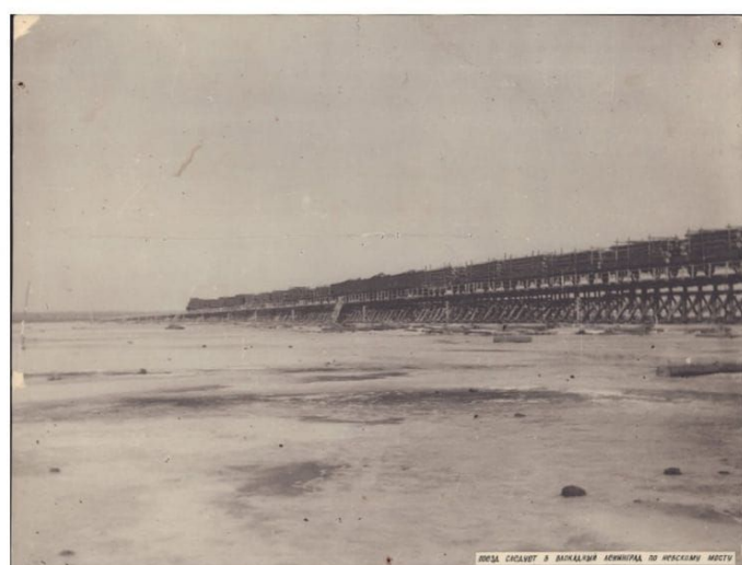
Первый поезд следует в Ленинград по временной свайной эстакаде через Неву. Фотограф – Г.И. Парицкий. 7 февраля 1943 г.
