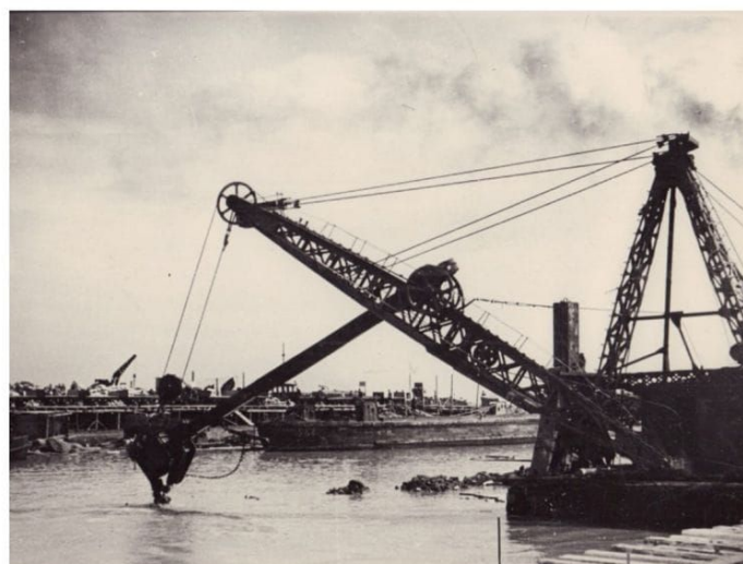
Работа землечерпательных снарядов на углублении дна у пирсов бухты Осиновец. 1942 г.
