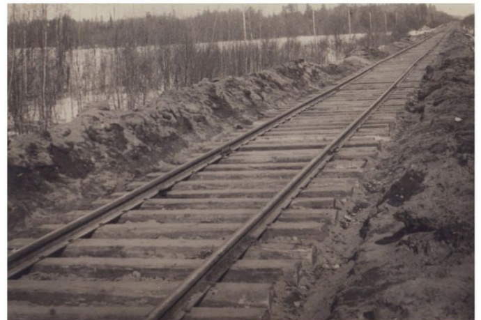
Восстановление пути на линии Веймарн-Сланцы. 1944 г.
