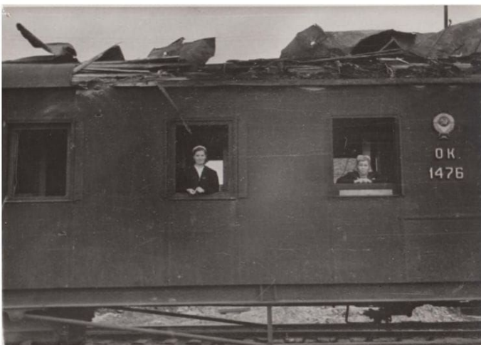
Разрушенный пассажирский вагон в депо Ленинград-Московский. 1941 г.
